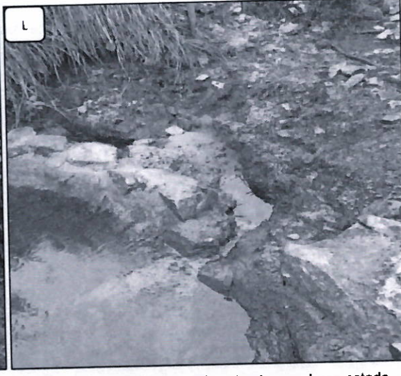
Fotografía 3: G: Captación 2-Santa Bárbara, H: Fuente de agua manantial desprotegido, I: Infraestructura en buen estado, J: falta cerco de protección, K: Presencia de charco de agua alrededor de la cámara húmeda, L: Ingreso de agua de fuente superficial a la captación.
