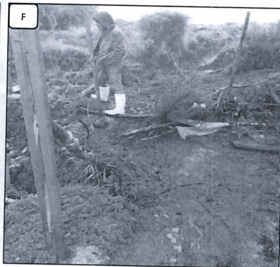
Fotografía 2: A: Captación 1-Santa Barbara, B: Fuente de agua manantial desprotegido, C: No hay cuneta de coronación, D: No hay tapa sanitaria en la caja de válvula de la cámara húmeda, E: Ingreso de agua de fuente superficial a la captación, F: Presencia de lodo y cerco perímetro en mal estado.
