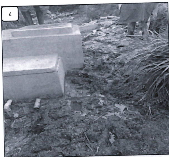
Fotografía 3: G: Captación 2-Santa Bárbara, H: Fuente de agua manantial desprotegido, I: Infraestructura en buen estado, J: falta cerco de protección, K: Presencia de charco de agua alrededor de la cámara húmeda, L: Ingreso de agua de fuente superficial a la captación.
