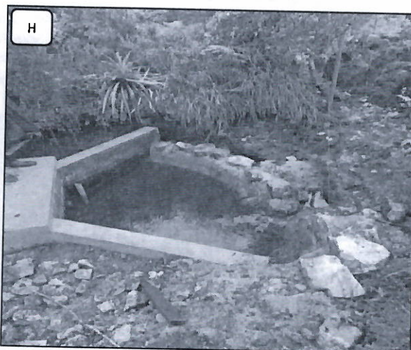
Fotografía 2: A: Captación 1-Santa Barbara, B: Fuente de agua manantial desprotegido, C: No hay cuneta de coronación, D: No hay tapa sanitaria en la caja de válvula de la cámara húmeda, E: Ingreso de agua de fuente superficial a la captación, F: Presencia de lodo y cerco perímetro en mal estado.
